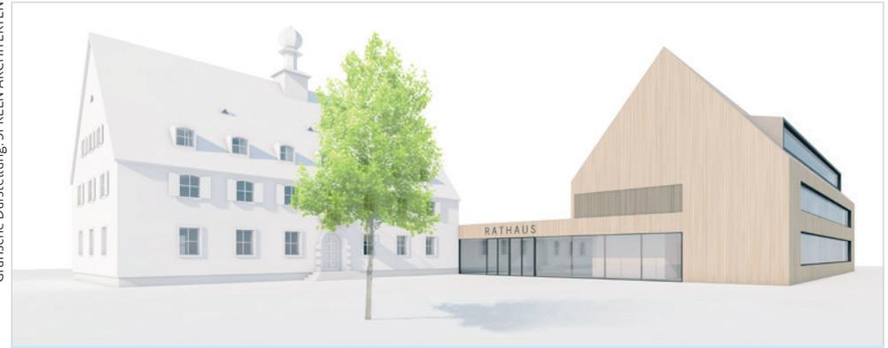
Ein Mix aus Holz und Beton kennzeichnet den Erweiterungsbau des Neubiberger Rathauses. Die Tiefgarage und das Untergeschoss werden in Betonbauweise erfolgen. Für den dreigeschossigen Erweiterungsbau, in dem die Büros der Beschäftigten der Gemeinde Neubiberg ihren Platz finden werden, soll überwiegend Holz verwendet werden. Mit dieser Bauweise können die Vorteile beider Materialien optimal genutzt werden.
